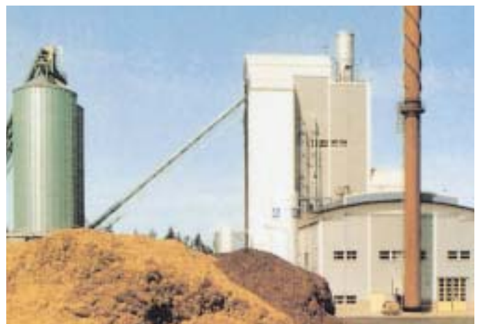
Planta de gasificació a alta pressió.
