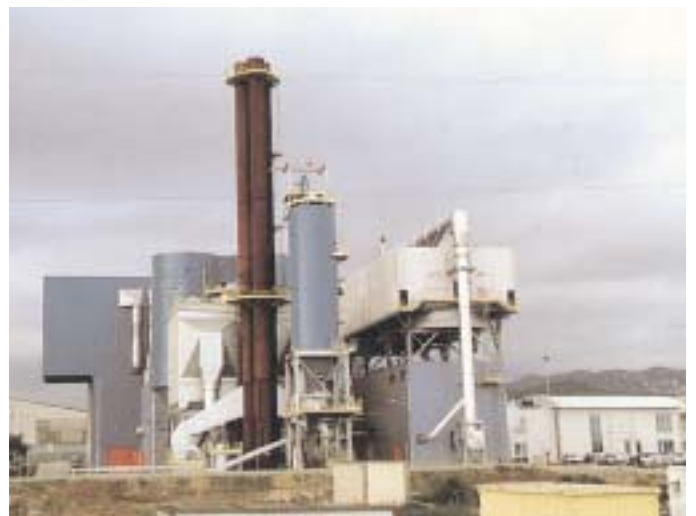
Centre de valoració energètica de les deixalles amb depuració i control de les emissions de fums.
